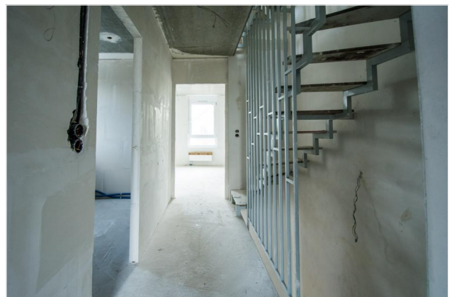
Baustelle Flur OG
