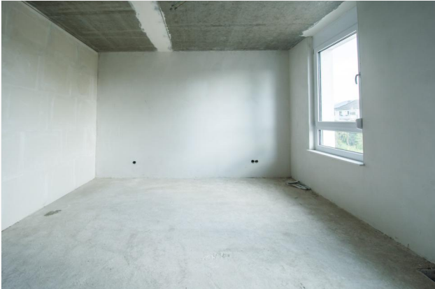
Baustelle Zimmer OG
